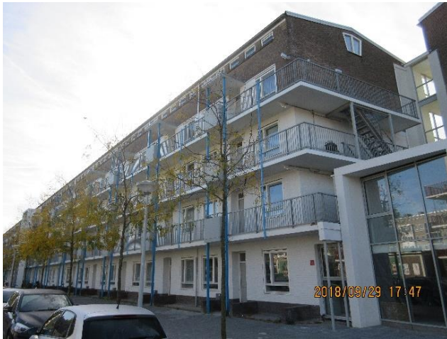
後付けのエレベーターへと続く新たな外部動線を設置
