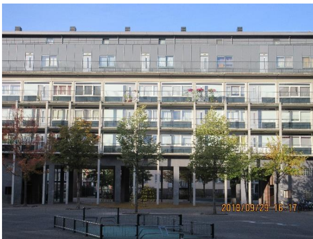
1階と2階部分一部を減築しピロティとし、屋上は増築
