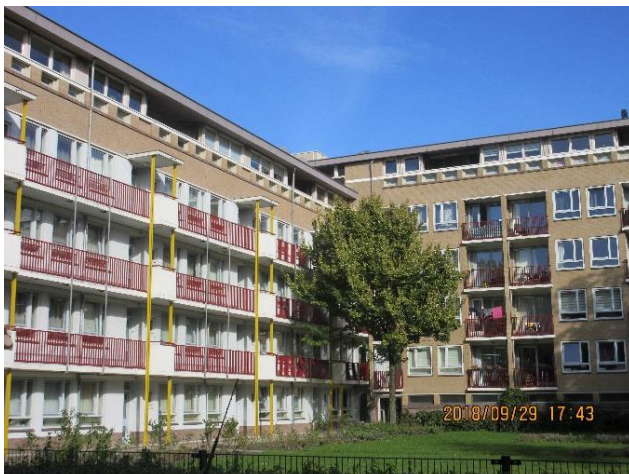
中庭を囲む形で建物を配置、張り出しバルコニーはスチール製
