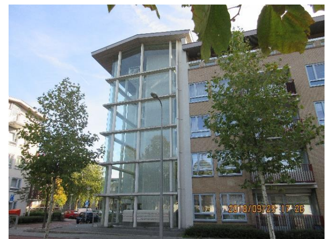
住棟角にはエレベーターを設置（ガラス部分）
