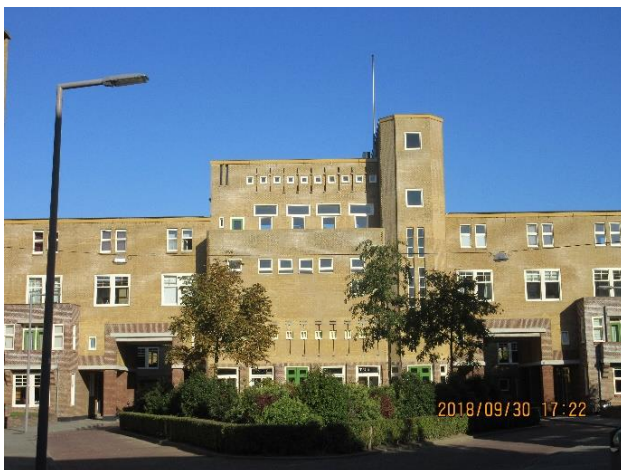
中央棟（内部には共同浴場、洗濯室など設置された）
