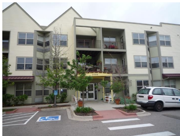
敷地の中央部に建つ高齢者住宅
